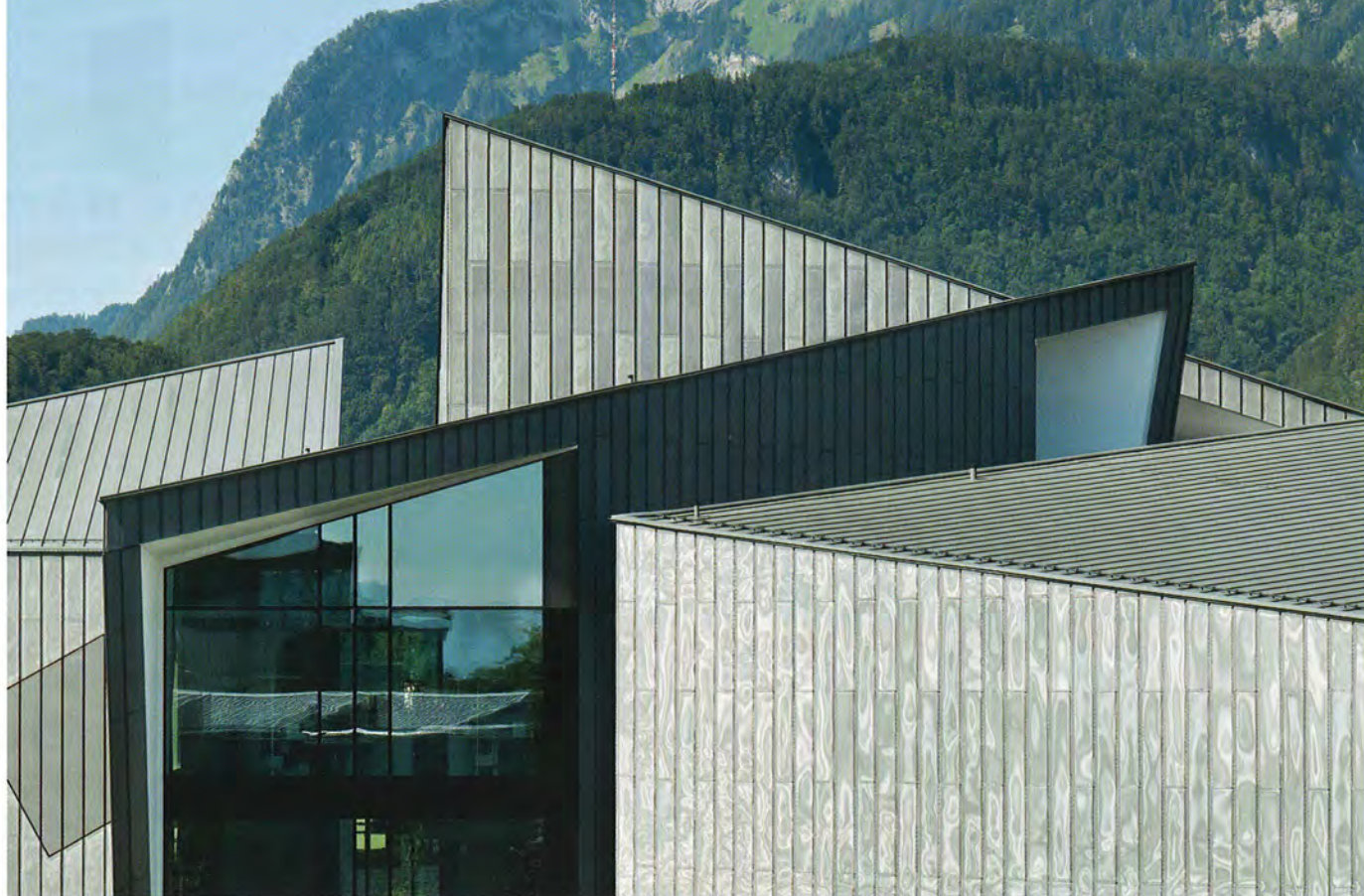
Dach und Fassaden fließen ineinander trotz Kantigkeit der Baukörper ..., exklusive Linienführung und Fenstereinbau... Foto: Pino Musi
