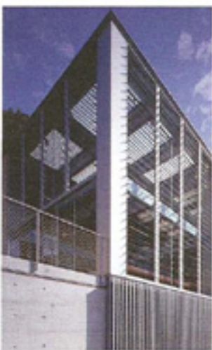
Figura 1: Vista facciata sud con la veranda in primo piano.
