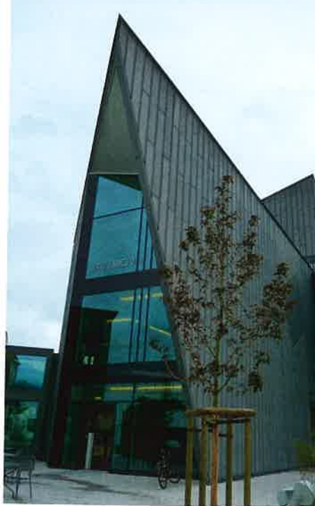
Eingangsbereich mit Jansen-Viss SSG-Verglasung und Streckmetall-Fassade.
