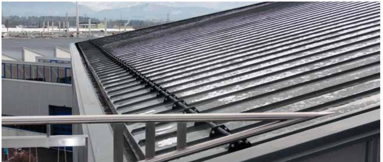
Doppelfalzdächer, die früher nur mit Bahnen bis 6m produziert werden konnten, können heute bei Einsatz eines geeigneten Maschinenparkes, Transportmöglichkeiten, Befestigungs- und Verbindungstechniken auch in grossen Längen, gemäss SIA-Norm 232 bis 16 m verlegt werden. Wichtig ist, dass die Bekleidung sturmfest und gleitend befestigt wird. Die Dachdeckungen des neuen Campus von Jansen waren insofern spannend, herausfordernd und boten die Chance, aktuelles Fachwissen um- und einzusetzen.
