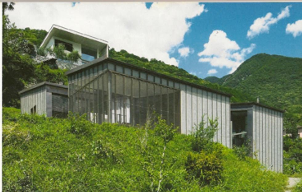
Die Hülle, welche das Volumen umfasst, verwandelt sich im Eckbereich in einen licht- und luftdurchlässigen Screen, der das Sonnenlicht filtert.
