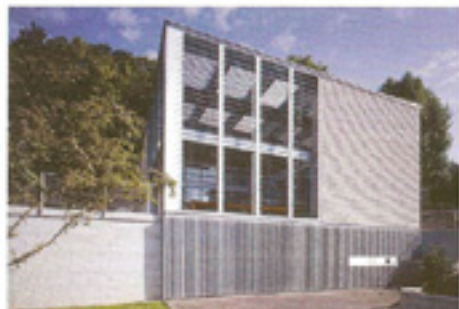
vista dell'esterno da sud
