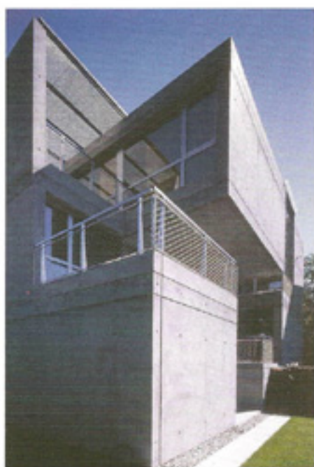
vista dell'angolo sud-ovest
