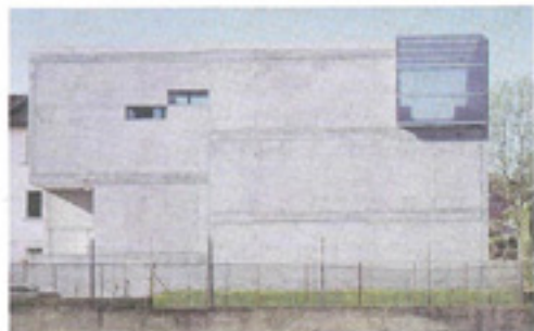
vista da nord
