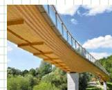
Hier hat das auf Holzbrücken und -tragwerke spezialisierte Ingenieurbüro Miebach eine Fahrrad- und Fußgängerbrücke in Blockträgerbauweise aus Holz errichtet, die über den Neckar führt und damit dem Wunsch der Einwohner nach einer Alternative zum vorigen, an der Straße entlangführenden Radweg nachkommt.
