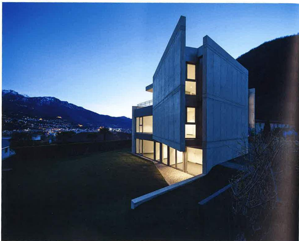
Exterior view Außenansicht Vue extérieure
